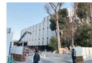
完成近い河北総合病院
