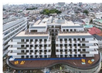
田中区政で整備した特養ホーム「フェニックス杉並」
